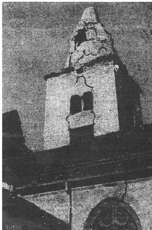
Notre-Dame-des-Marais, Sierre, après le séisme de 1946 (Nouvelliste du 30.01.1946)
